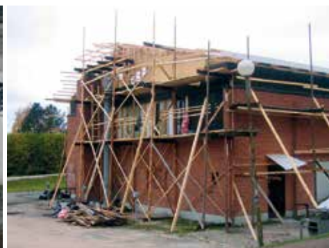
3. Byggnadsställningar av en alldeles egen ideell modell.
